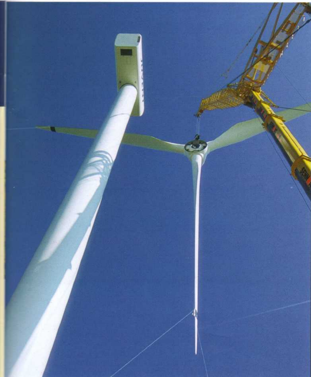
Automne 2004: les deux plus grands camions-grues de Suisse installent la 8 e éolienne du parc de Juvent SA, à Mont-Soleil.
